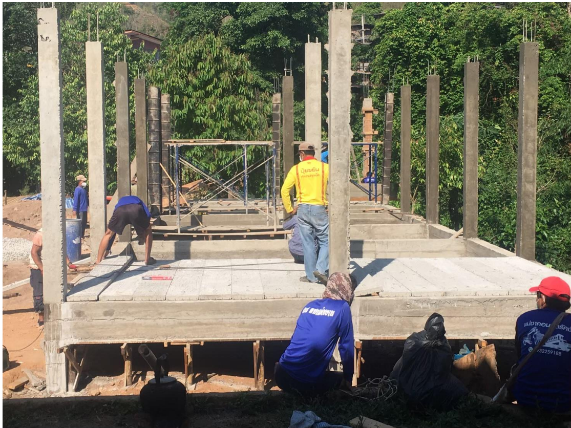
ก่อสร้างอาคารเรียนอนุบาลโรงเรียนบ้านแม่ซา
